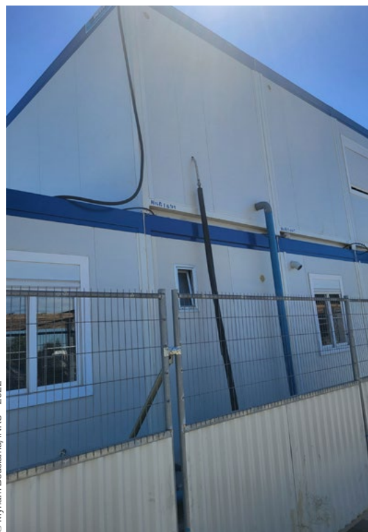
■ Figure 5. Séparation de la canalisation d'eau propre et d'eau usée La canalisation d'eau froide est calorifugée.
