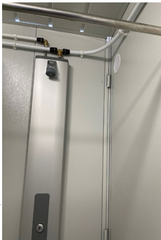
■ Figure 4. Installation d'une cabine de douche avec un coude à grand rayon
