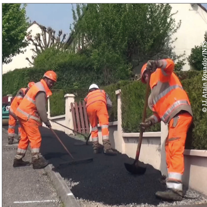
Photo 1 : Mise en œuvre manuelle d'enrobés sans dispositif d'assistance physique
